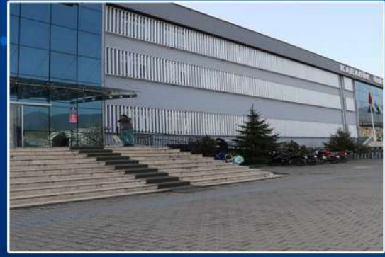
Teknoloji Fakültesi dersliklerin aşırı ısınmasını önlemek amacıyla güneş kırıcı uygulaması
